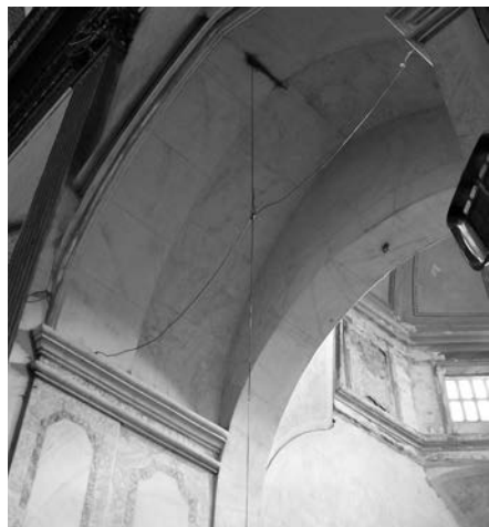
FIGURA 5. Pas de la capella de Sant Joan on es pot observar encara la fondària original de les capelles laterals gòtiques amb l'arc i volta apuntats (J. Graupera, 2006).
